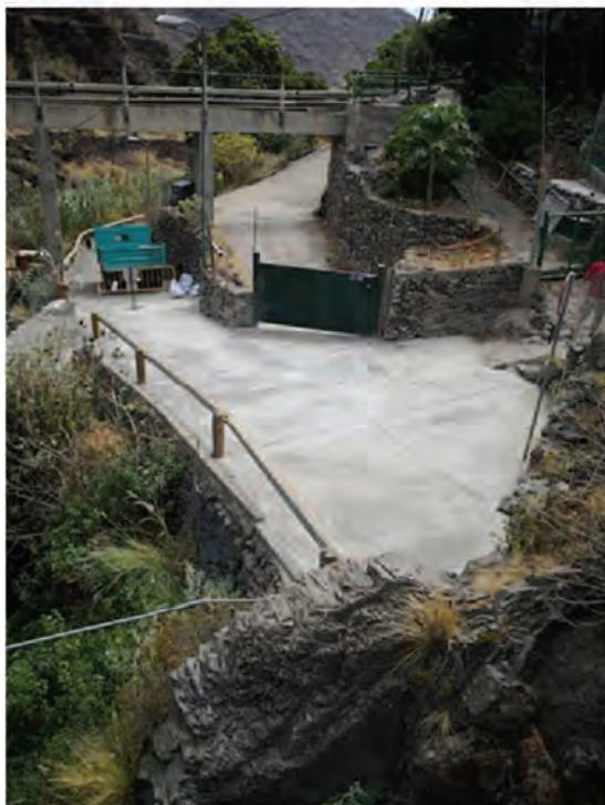
ción posterior de una solera de hormigón armado HM-25/B/20/I de 9 cm de espesor, en una superficie total de 534,13 m<sup>2</sup>. (41.623,00 €)
