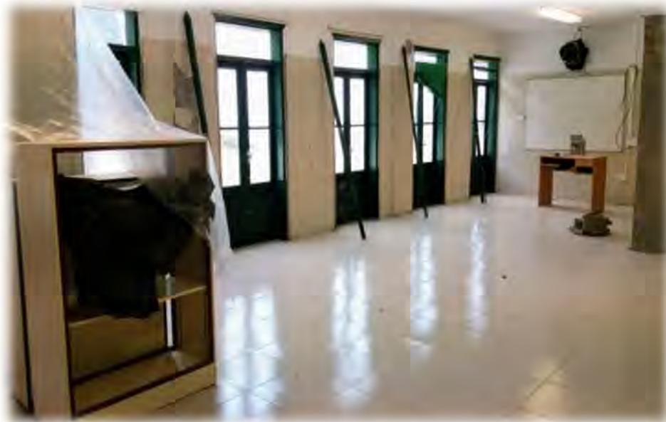
Las obras comenzaron con la retirada de los antiguos azulejos, en muy mal estado, así como el arreglo del techo, cuya estructura se hallaba debilitada, el cual se ha empezado a picar para su nuevo encalado. Además, las puertas (casi ni cierran), muy deterioradas y que dejan pasar la humedad, se espera que sean sustituidas.
