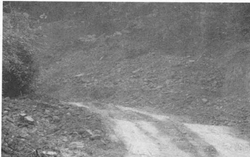
Estado de una de las carreteras después de los desprendimientos ocasionados por las fuertes lluvias
