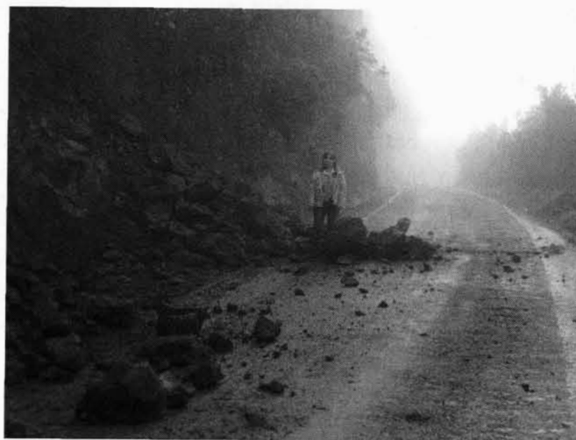
Uno de los muchos derrumbes en la carretera de Chamorga.
