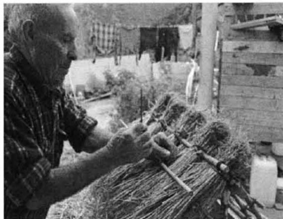
La maqueta se ha venido construyendo desde al año 2011, utilizando una serie de medidas y materiales, indicados por el maestro tapador. Este pajar en miniatura, recoge la técnica utilizada en esta zona de la Isla y se compone de paja, madera y piedras obtenidas del Roque Negro, risco que da nombre al conocido caserío de Anaga.
