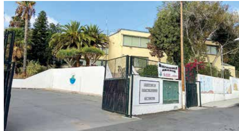
CEIP Los Campitos. Instalaciones del colegio de Los Campitos.
