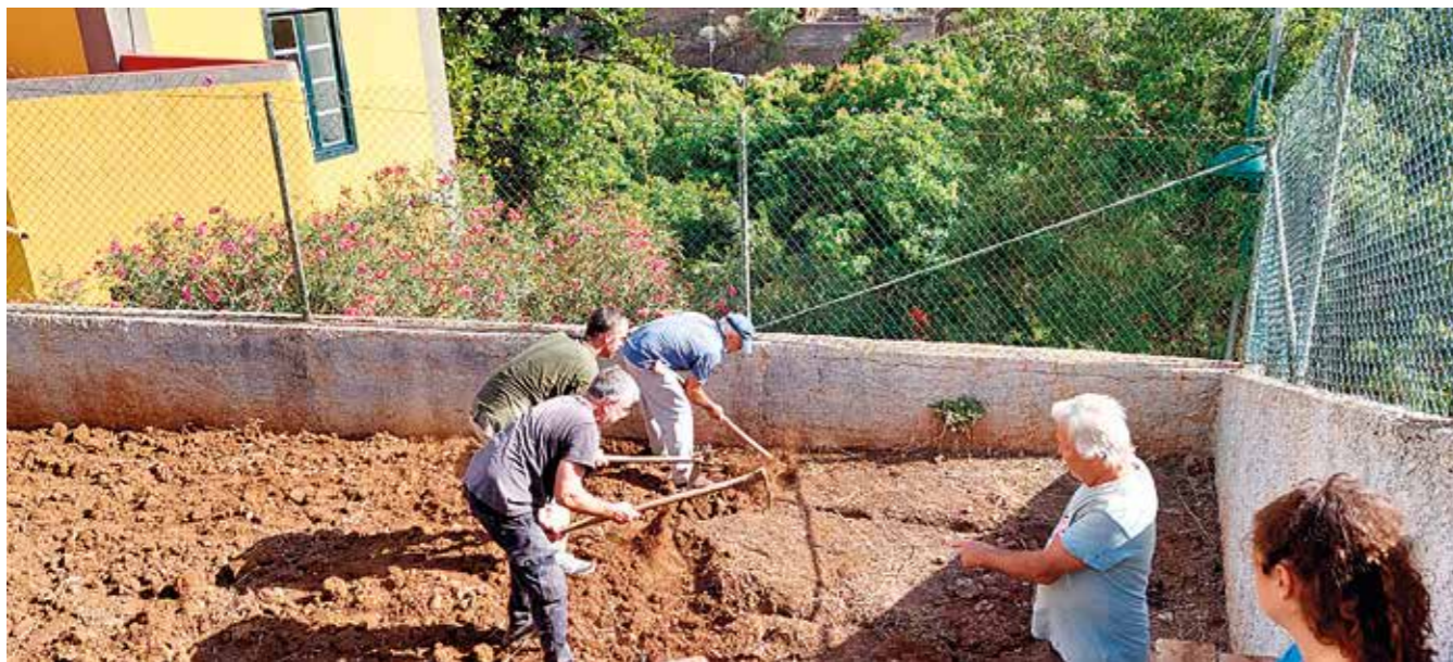
Trabajos de acondicionamiento y vallado.
