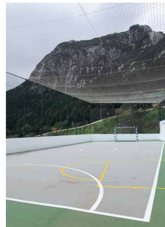
Obra de la cancha finalizada.
