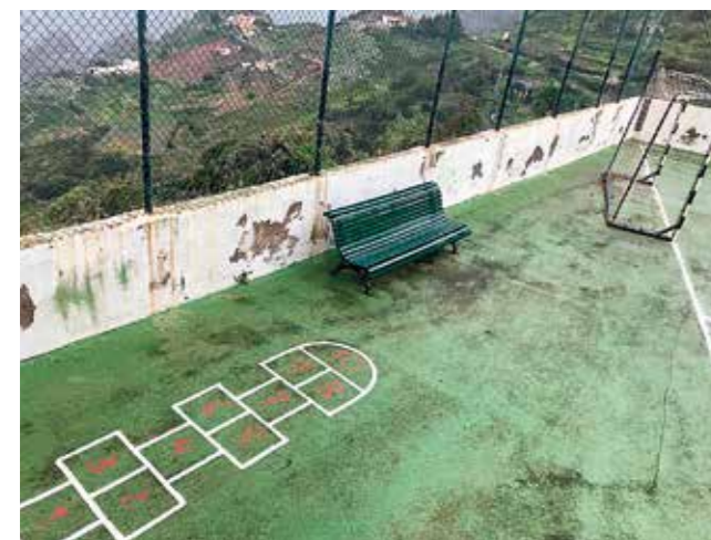
La cancha de Roque Negro antes de las obras.
