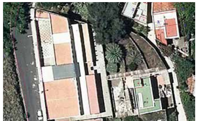
Encontramos 3 terrazas conectadas por una escalera. La superficie de las terrazas es similar, de aproximadamente 100 m 2 cada una.
